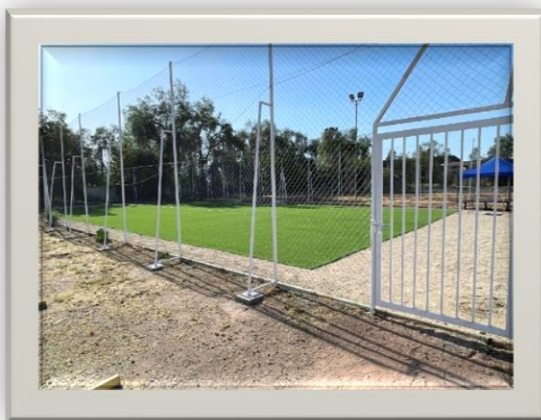
Espacio deportivo sector San Ramón
